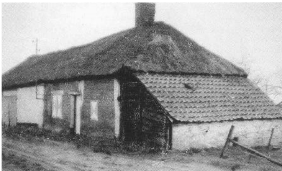
Zo zag het huis van de Lilse zeeldraaier Louis Henrothay op bet Rolleken eruit. Het dak was van stro, de muren gedeeltelijk van leem en de rest van bakstenen. Deze foto werd genomen in 1957. Foto: Jos Aerts.
